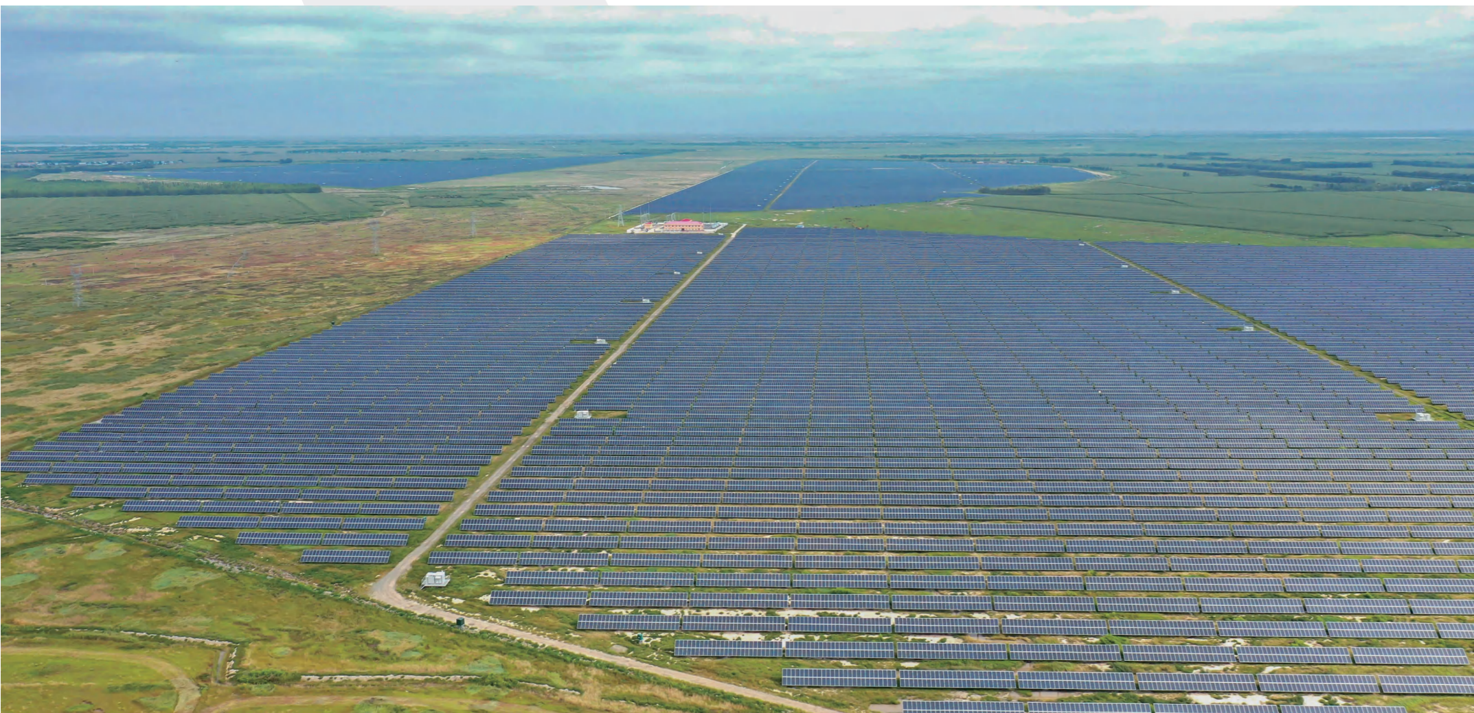
黑龙江 安达 500MW 地面电站 2021年 双玻375W/445W
