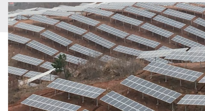
贵州 晴隆 90MW 地面电站 2021年 单玻445W
